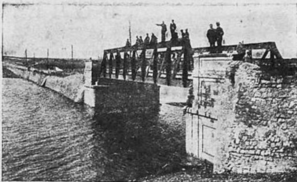
У нас построили новый железобетонный мост (с. Тягилка)
